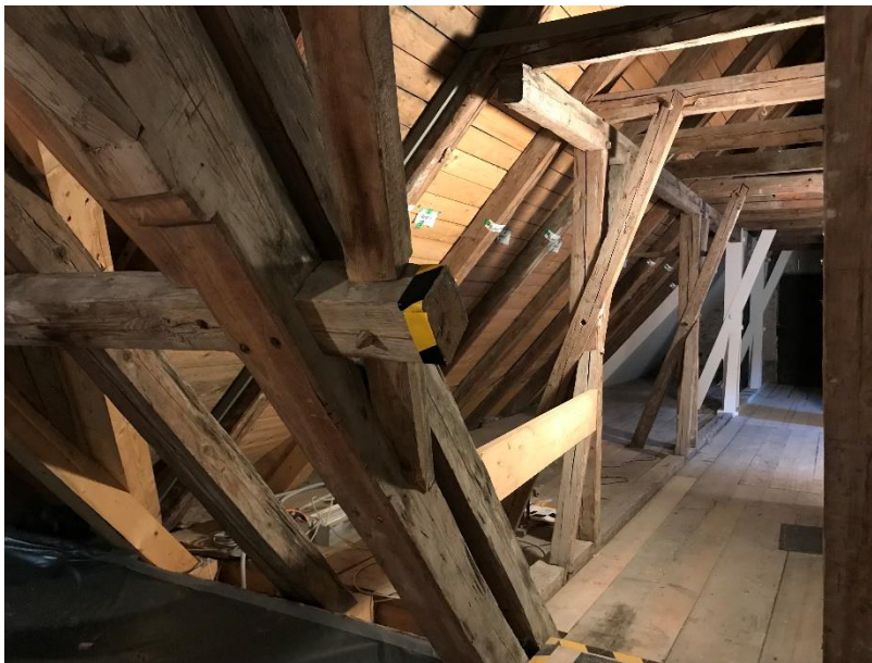
Abbildung 4: Sanierter Dachstuhl der „Alten Schäfllerei“, Fraunhofer Zentrum Benediktbeuern (Bildquelle: Pamela Jentner)
