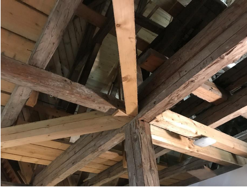
Abbildung 5: Saniertes Dachgebälk, „Alte Schäfflerei“. (Bildquelle: Pamela Jentner)
