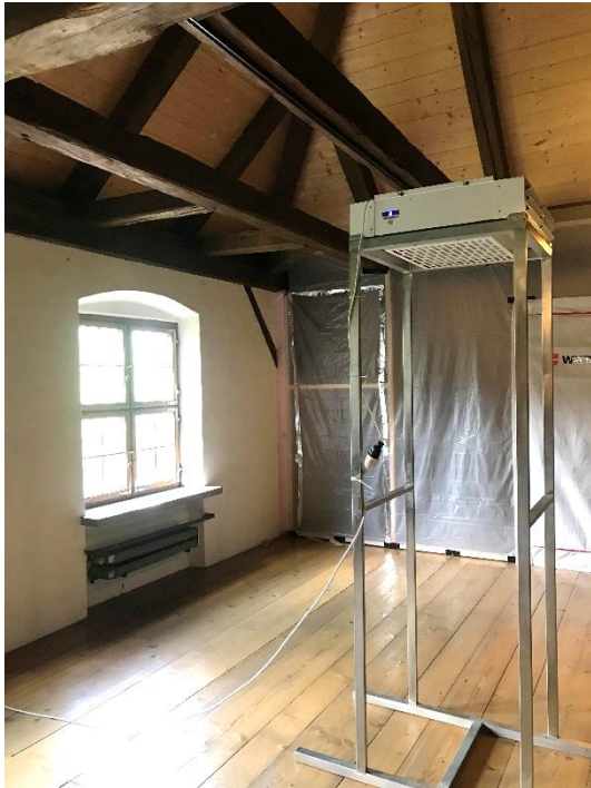
Abbildung 2: CycloPlasma-Anwendung im Dachstuhl der Thürlmühle, Freilichtmuseum Grentleiten. (Bildquelle: Pamela Jentner)
